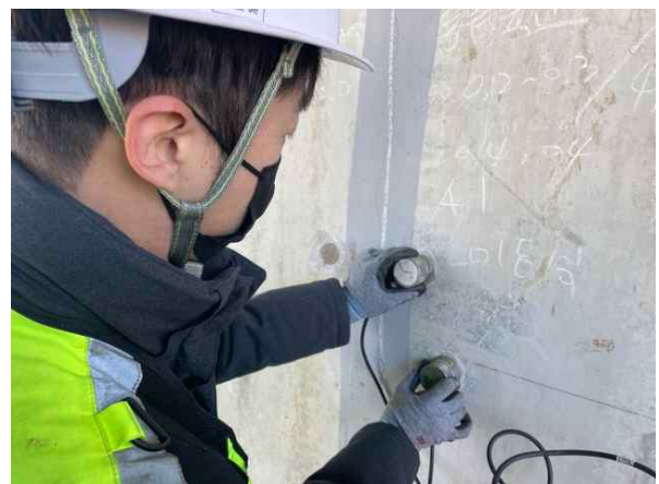
균열깊이 측정 전경
