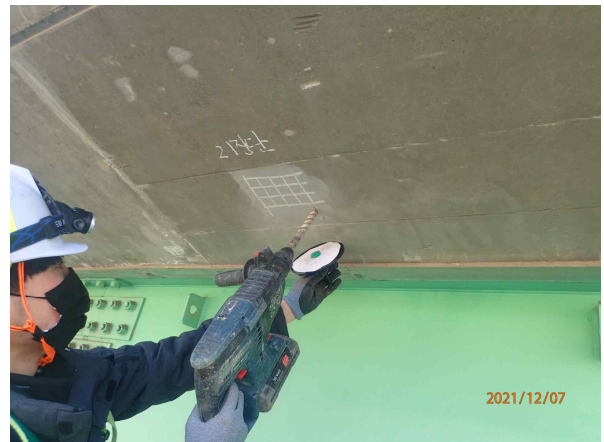
탄산화깊이 측정 전경
