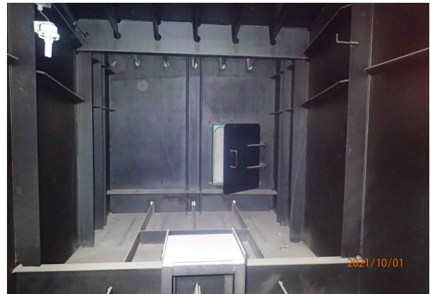
STB 거더 내부 전경
