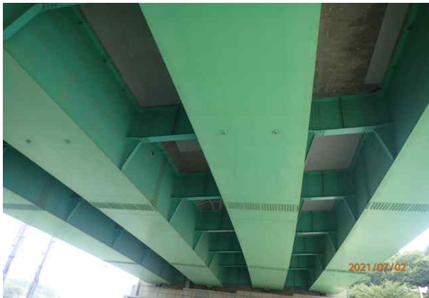
STB 거더 외부 전경
