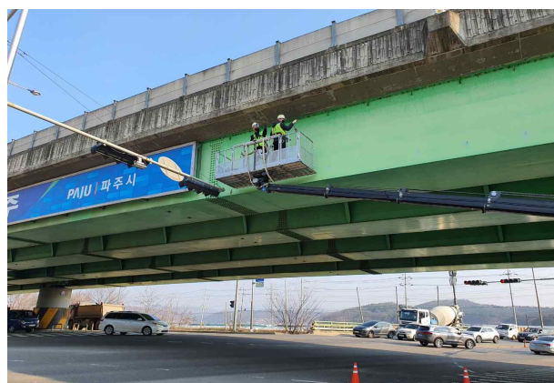
고소점검차를 이용한 외관조사
